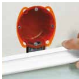
Проверка правильности расположения коробки и мини-каналов
