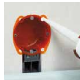
Крепление при помощи захватов и посадка на клей
