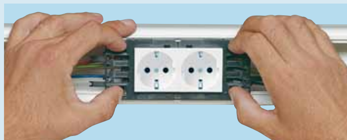
Монтаж розеток Mosaic в кабель-каналы DLP
