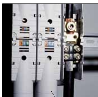
Соединение медных и алюминиевых проводников
