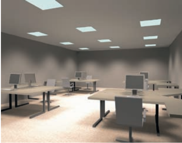
Рис. 2. Офис, освещенный с помощью приборов PRBLUX 418, расставленных полем UGR < 10 , E_{\text{ср}} = 463 лк, удельная мощность 15 \text{ Вт/м}^2
