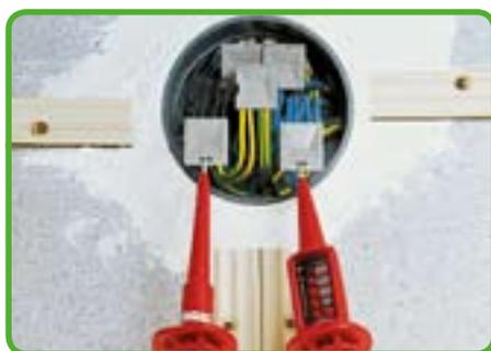
Контроль наличия напряжения на примере розеточных клемм.
