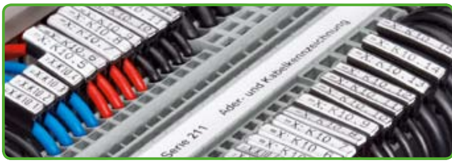
Маркировка с помощью гильзы.
