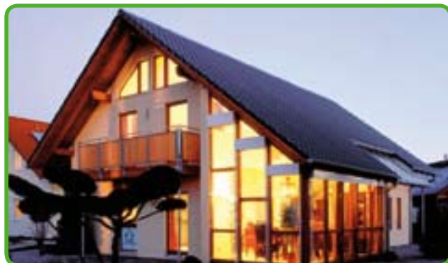
Строительство сборных домов
