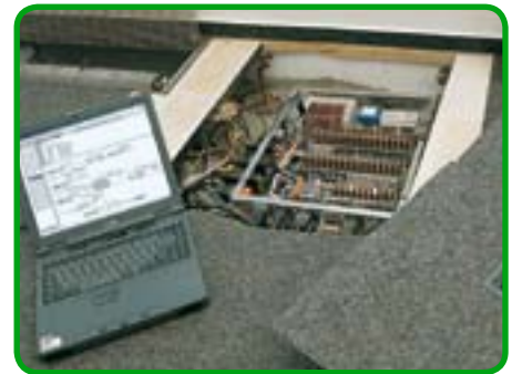
Распределительные коробки под полом
