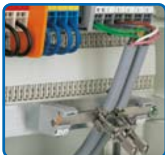
Установка на сборную шину с кронштейнами.
