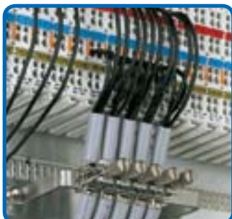
Медная скоба сборной шины 10 x 3 мм/0,394 x 0,118 дюйма
