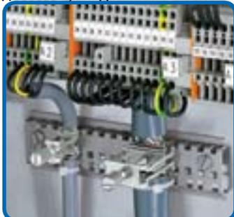
Установка на перфорированный монтажный рельс.
