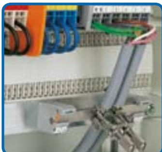
Установка на сборную шину с кронштейнами.
