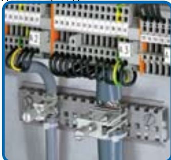
Установка на перфорированный монтажный рельс.
