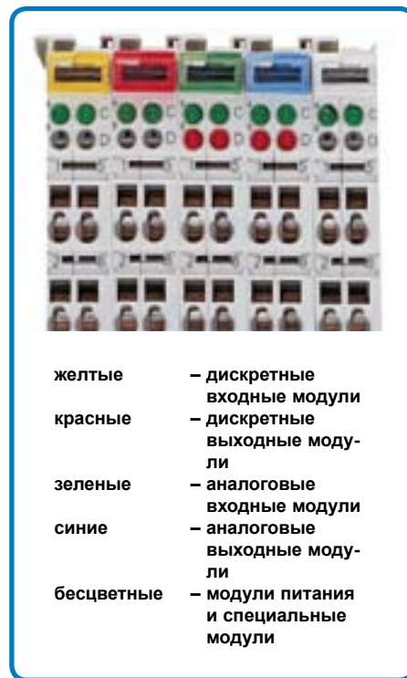
Разные по функциям модули промаркированы групповыми прозрачными маркерами разного цвета.
