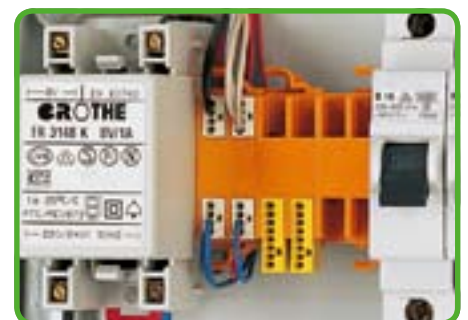
Применение в системе дверного звонка— монтаж на TS 35
