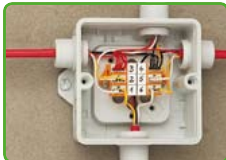
Распределительная коробка охранной сигнализации – винтовой монтаж.
