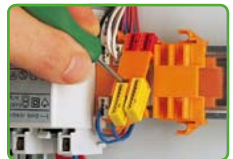
Демонтаж клеммы MICRO PUSH WIRE® с адаптера.
