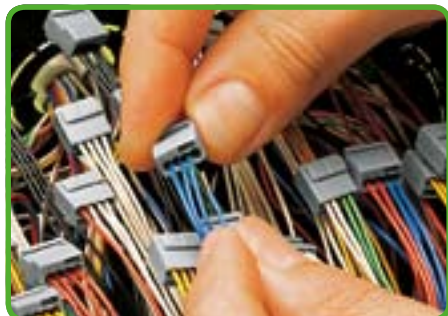
Подсоединение: проводник без изоляции вставьте до упора.
