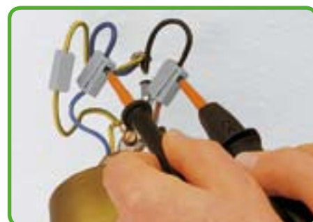
Измерение через отдельное тестовое гнездо.
