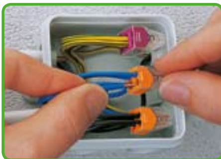
Подсоединение: введите одножильный проводник со снятой изоляцией до упора
