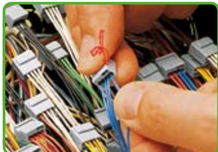
Отсоединение: удерживая проводник и прокручивая его вправо-влево, извлечь из клеммы.
