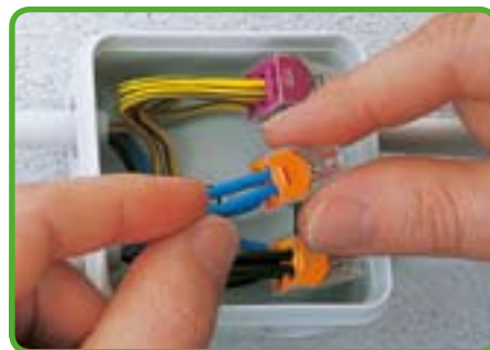
Отсоединение: удерживая проводник и прокручивая клемму вправо-влево, стяните ее с проводника.
