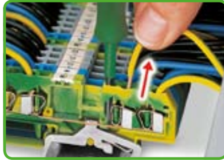
Демонтаж проводника с помощью отвертки
