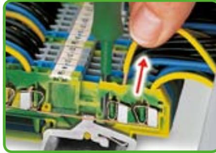
Демонтаж проводника с помощью отвертки
