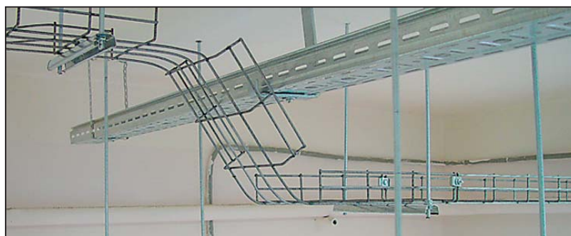
Пример монтажа кабельной трассы
