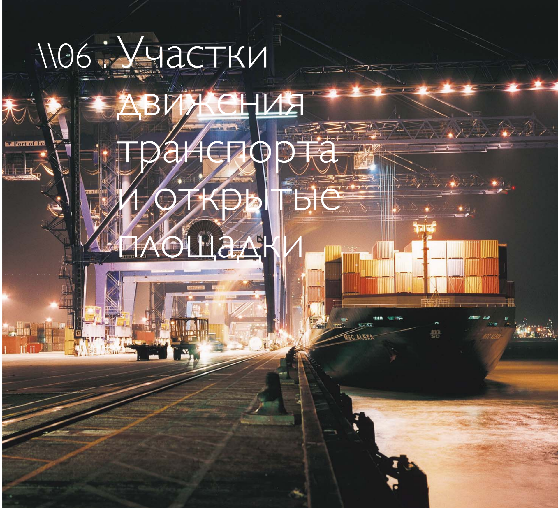
Контейнерный терминал, г. Феликстоу, Великобритания
