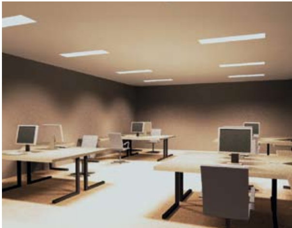
Рис. 3. Офис, освещенный с помощью приборов PTF 228, расставленных над рабочими местами UGR < 10 , E_{cp} = 548 лк, удельная мощность 8,5 Вт/м 2 .
