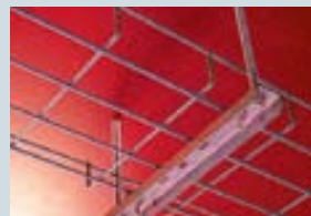
■ Подвес на шпильке с применением профиля ПП100
