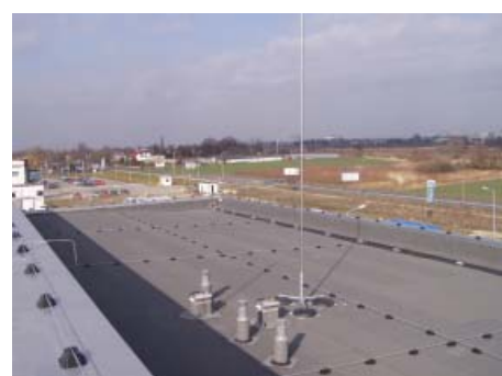
Совместное использование молниеприемной мачты и сетки.
