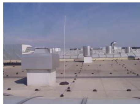
Молниеприемная сетка, смонтированная с помощью пластиковых держателей с бетоном.
