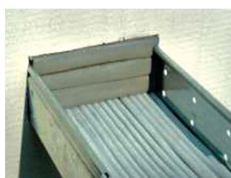
Проходки из огнезащитных пеноблоков
