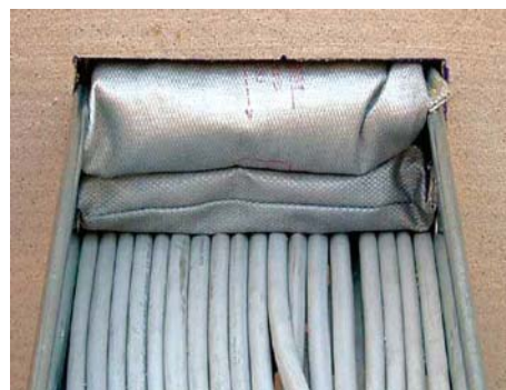
Проходки из огнестойких подушек
