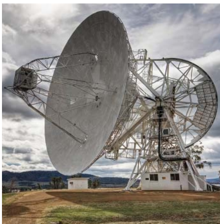
Системы управления и телекоммуникации
