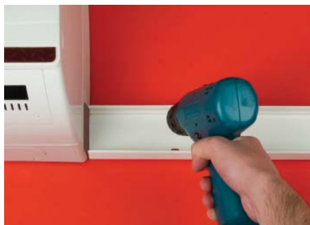
Закрепите основание короба на стене
