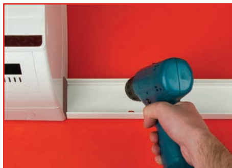
Закрепите основание короба на стене
