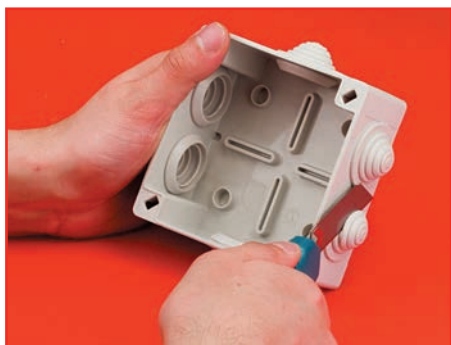
Срезаем кабельный ввод
