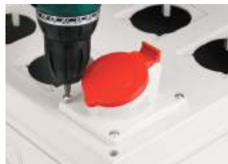
Монтаж розетки на 32 А
