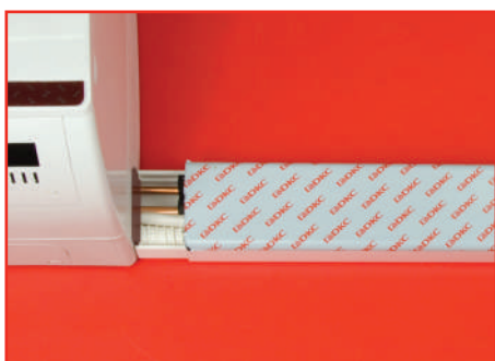
Закройте смонтированную трассу крышкой
