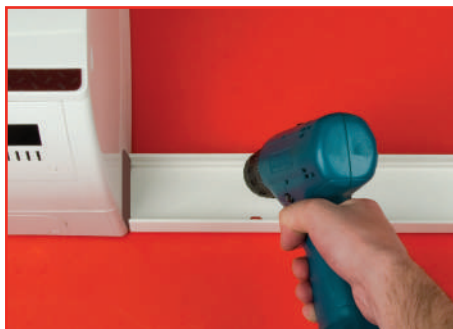
Закрепите основание короба на стене
