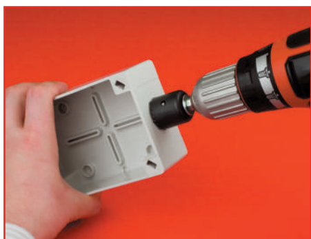
1 этап. Сверлим отверстия необходимого диаметра
