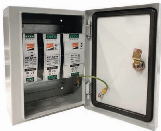
Пример установки блоков питания BSPS DIN на DIN-рейку в электрическом шкафу
