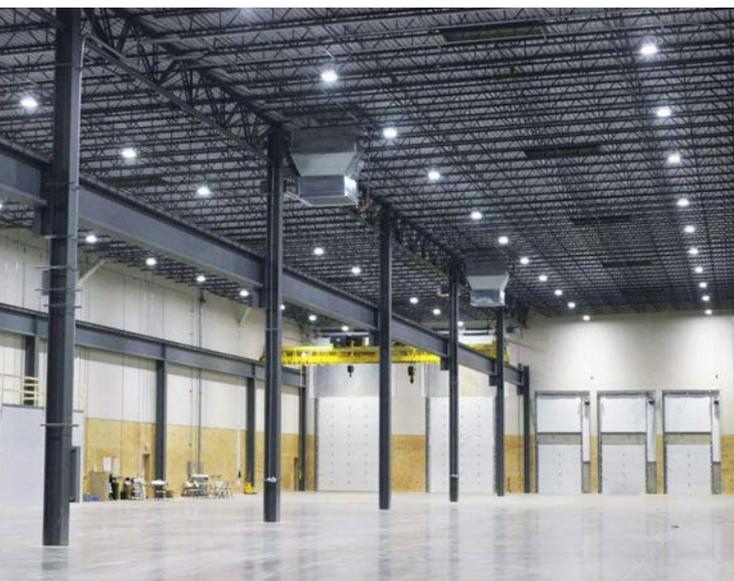
Высокая энергоэффективность 100lm/W. Применяются для освещения складских, торговых и производственных помещений с высокими потолками (более 4 м). Используются в качестве энергоэффективной альтернативы светильникам с ДРЛ, МГЛ и лампами ДНАТ. Благодаря отсутствию пульсации освещенности светильник не оказывает вредного воздействия на зрение.
