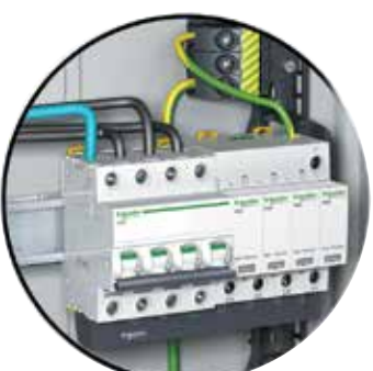
Ограничитель перенапряжения iPRD 4P + iC60N 4P
