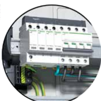
Ограничитель перенапряжения iPRD 4P + iC60N 4P
