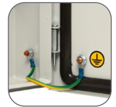
Обмедненные шпильки заземления. Закрепленный поводок заземления
