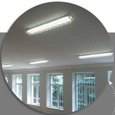
Решетка защитная для линейных светильников служит для надежной защиты рассеивателей светильников от механических повреждений и попадания постоянных предметов. Идеально подойдет для установки в спортзалах, на складах, производствах, парковках и пр.
