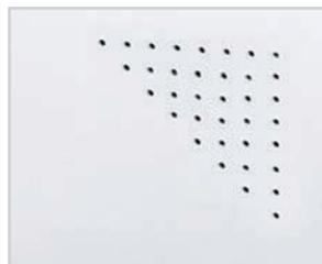
Перфорация дверцы бокса способствует пропуску радиосигнала.
