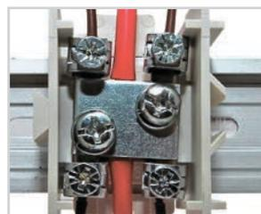
Обеспечивает подключение до четырех проводников, не нарушая целостности токоведущей жилы центрального проводника.
