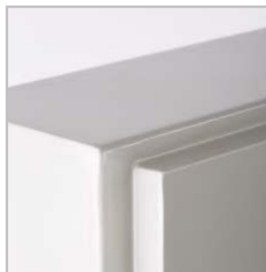
Полностью проваренные швы.
