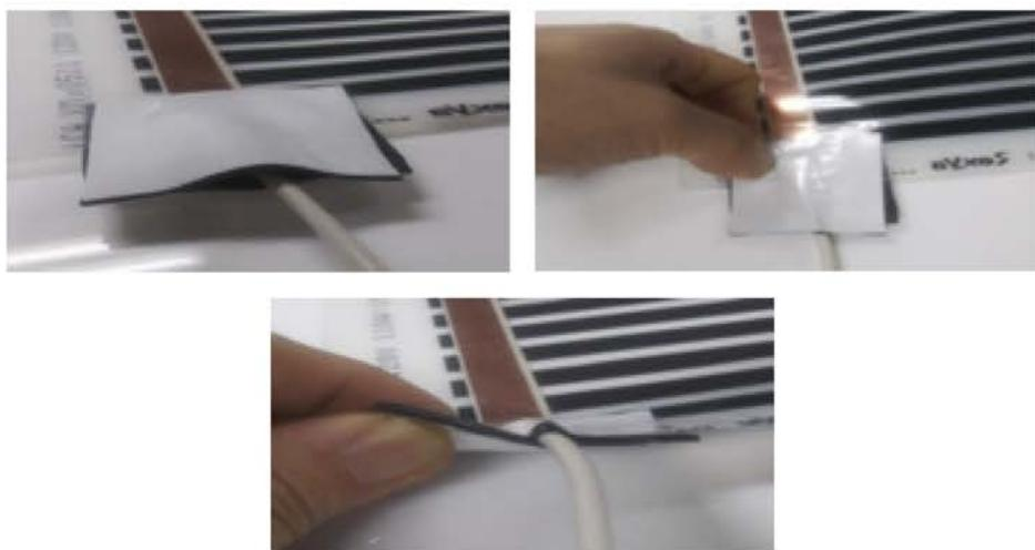
– Также заизолируйте места разреза медной шины, где не планируется подключение проводов.
