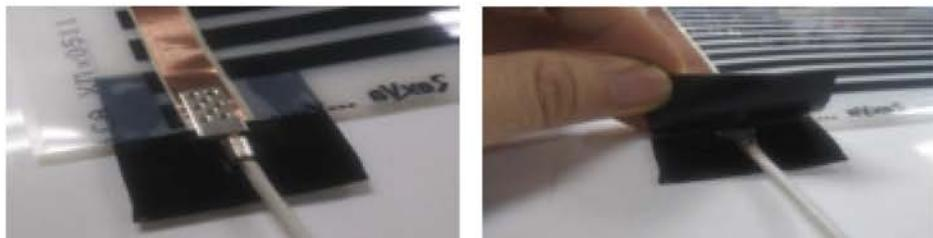
– Удалите оставшийся воздух между верхней и нижней частью битумной изоляции. Надавите на место, где расположен зажим и провод, для лучшей изоляции.
