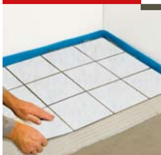
Укладка плитки из натурального камня
