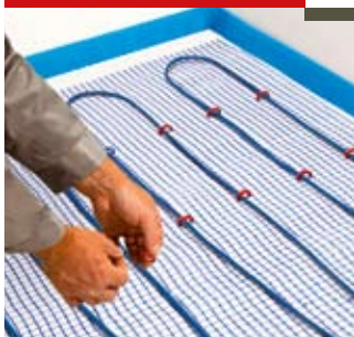
Укладка греющего кабеля
