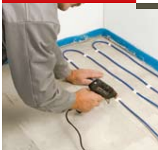
Укладка греющего кабеля
