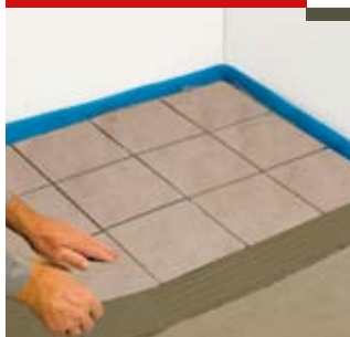
Укладка керамической плитки
