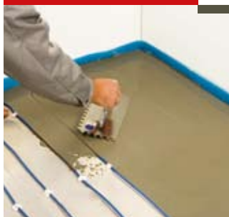
Нанесение выравнивающей стяжки
