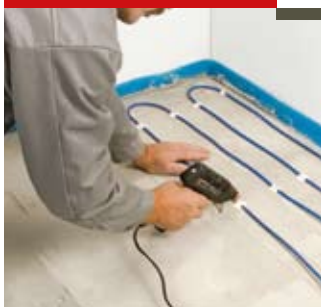
Укладка греющего кабеля
