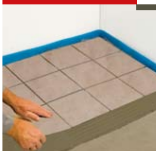
Укладка керамической плитки
