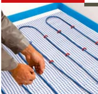
Укладка греющего кабеля
