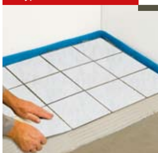
Укладка плитки из натурального камня
