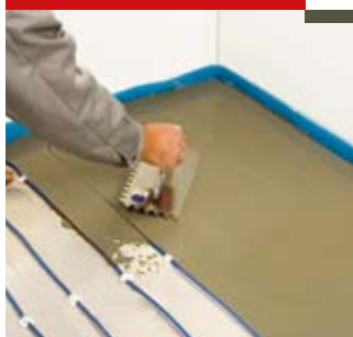
Нанесение выравнивающей стяжки
