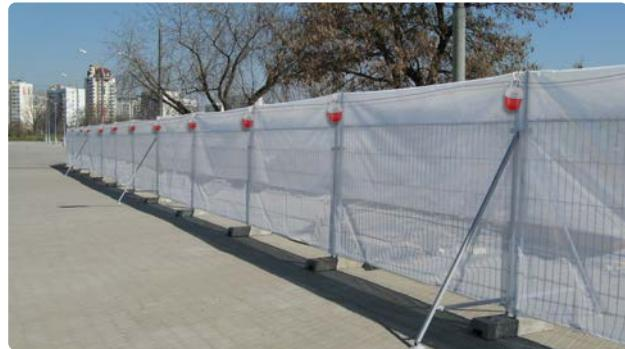
**Сигнальные светодиодные фонари ФС-12 Navigator** серии **NRL-01** предназначены для обозначения зон дорожно-ремонтных и строительных работ.
