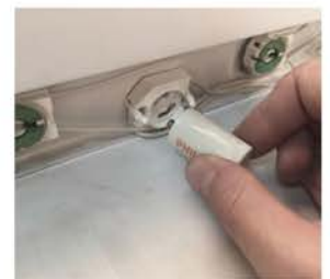
4. Для этого нужно, удерживая пускатель за корпус, повернуть его на 90° против часовой стрелки, после чего потянуть для извлечения из патрона. Повторить для всех установленных пускателей.
