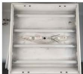
6. Устанавливаем светодиодные лампы SAFFIT.
