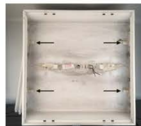
3. Извлекаем старые люминесцентные лампы. Теперь нужно удалить пускатели (стартеры), которые обозначены стрелками.
