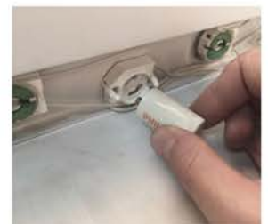
4. Для этого нужно, удерживая пускатель за корпус, повернуть его на 90° против часовой стрелки, после чего потянуть для извлечения из патрона. Повторить для всех установленных пускателей.
