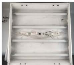
6. Устанавливаем светодиодные лампы SAFFIT.
