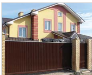
Ворота с автоматическими приводами.
