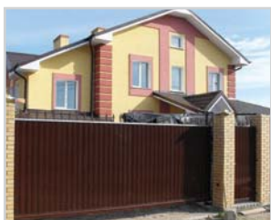
Ворота с автоматическими приводами.
