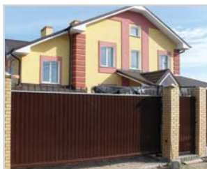
Ворота с автоматическими приводами.
