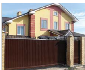
Ворота с автоматическими приводами.
