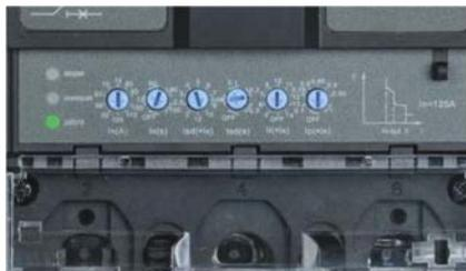
Выключатели с электронным расцепителем имеют 6 регулировок под любой тип нагрузки и селективности двух последовательно включенных устройств.
