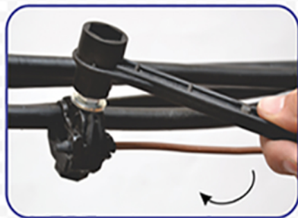
4. Затяжка верхней части головки на зажиме с помощью изолированного ключа ОК 13, в направлении по часовой стрелке
