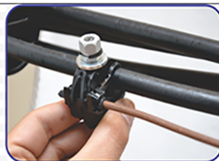
3. Монтаж зажима на магистральный провод
