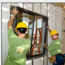
Крепление оконных рам к различным видам оснований
