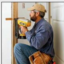
Крепление дверных рам к различным видам оснований
