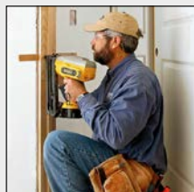
Крепление дверных рам к различным видам оснований
