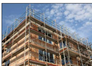
Монтаж строительных лесов.
