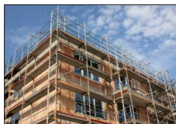
Монтаж строительных лесов.
