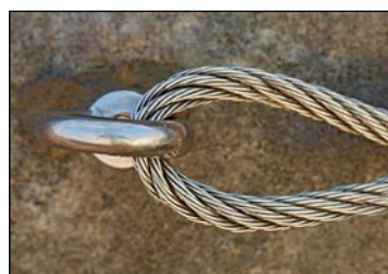
Монтаж такелажных систем.
