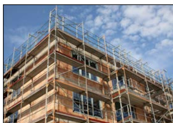
Монтаж строительных лесов.
