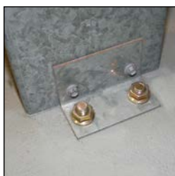
Крепление самонесущих конструкций.
