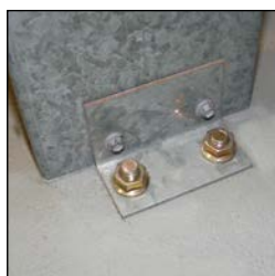
Крепление самонесущих конструкций.
