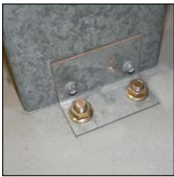
Крепление самонесущих конструкций.
